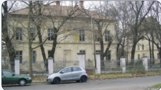
Felújításra várnak a laktanya romosodó épületei
