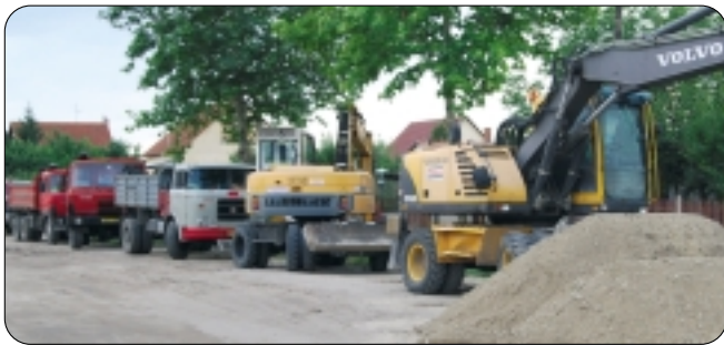
Két éve megtorpant a vízvezeték kiépítése
